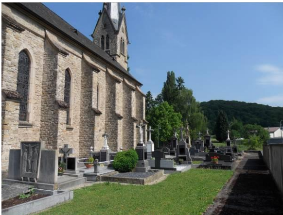
Trintange, rue de l'Eglise – l'église de Trintange avec son mobilier et le cimetière adjacent
