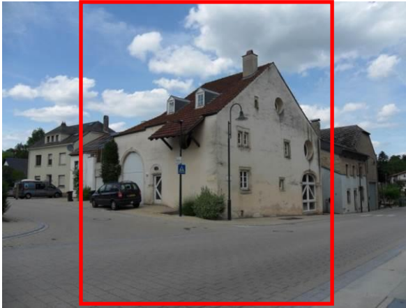
2, rue de Trintange – corps de logis + annexes
