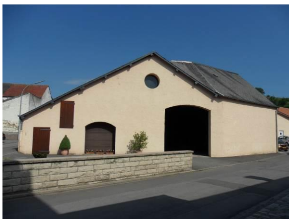
19, rue du village – bâtiment dans son ensemble
