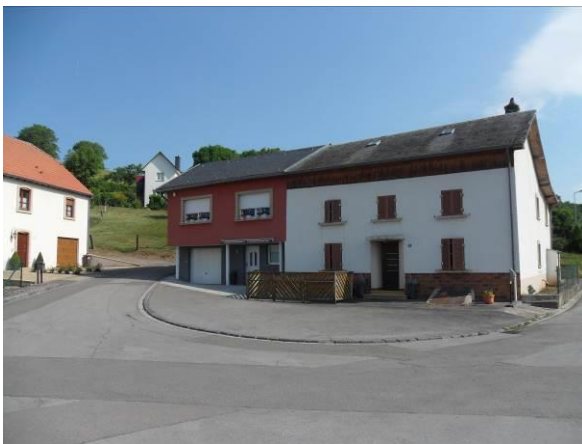
10-12, rue du Village – bâtiments dans leur ensemble
