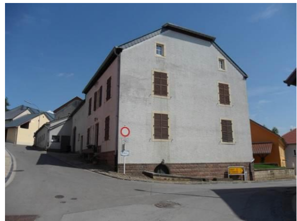
4, rue du Bassin – corps de logis + annexes
