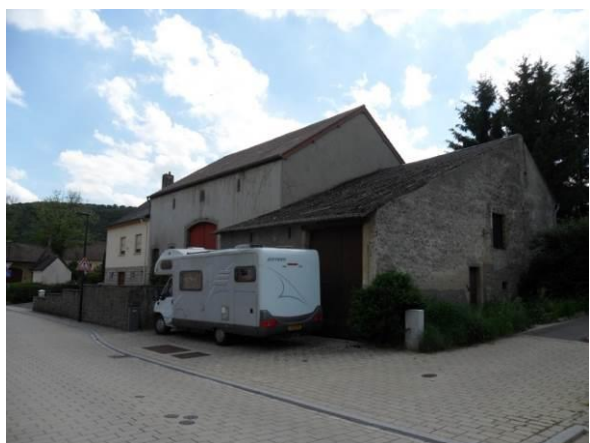
1, rue de Trintange – corps de logis + annexes
