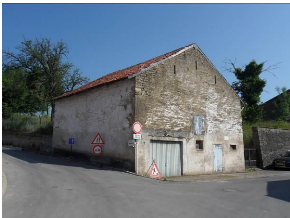
Rue de Moutfort / rue du village – grange
