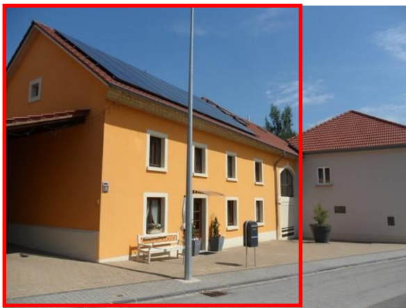
5, rue de Canach – volume principal
