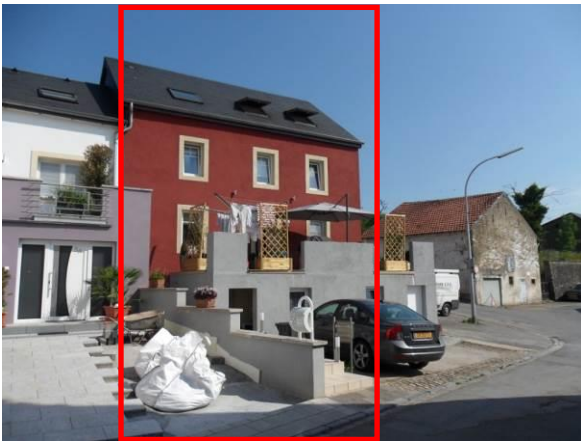
3, rue de la Forge – volume principal
