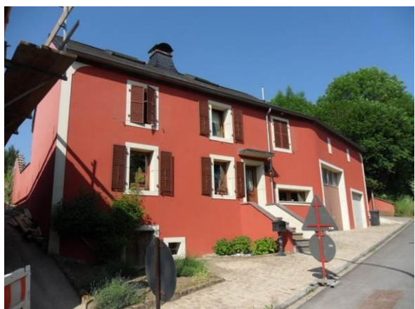
3, rue de Moutfort – bâtiment dans son ensemble
