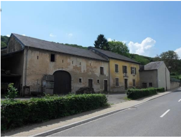
1, rue de Gondelange – annexes + corps de logis
