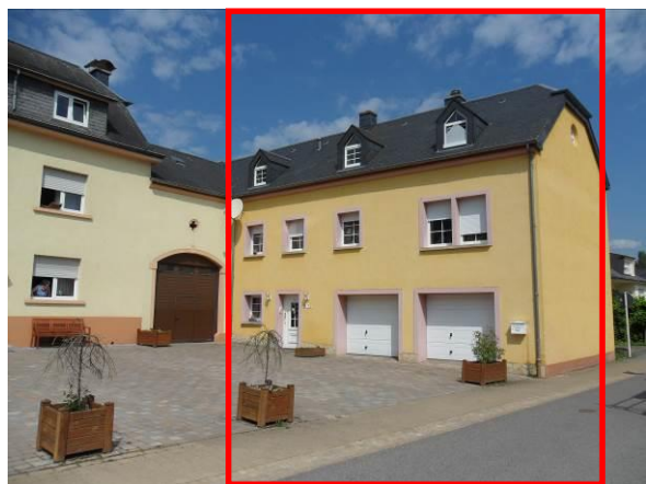
10A, rue Principale – bâtiment dans son ensemble
