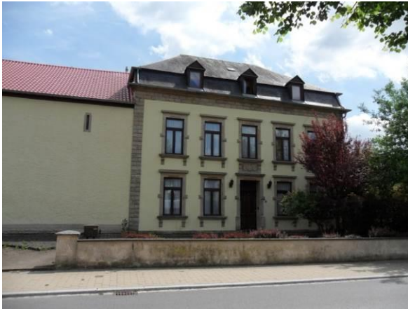
15, rue Principale – corps de logis + grange (détail)
