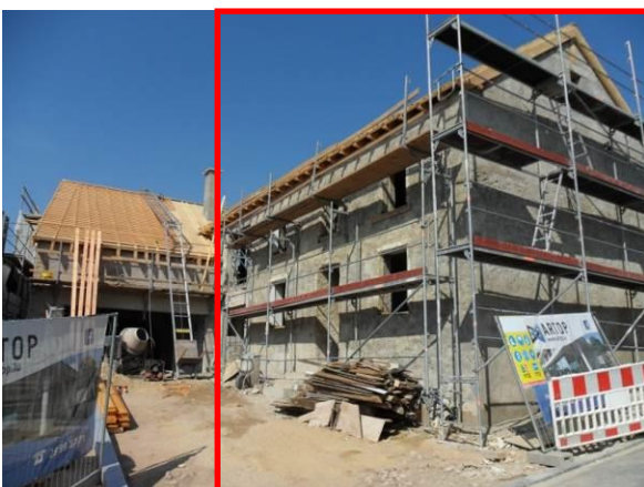
1, rue de Moutfort – volume principal
