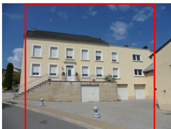
6, rue de la Montagne – volume principal
