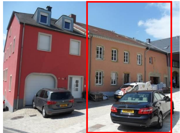
1, rue du Bassin – bâtiment dans son ensemble
