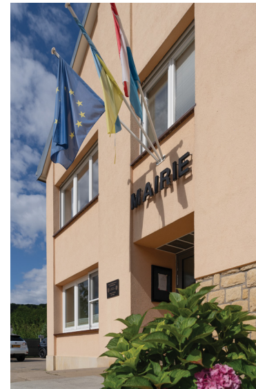
Mairie de Trintange 27, rue de l'Eglise L-5460 Trintange
