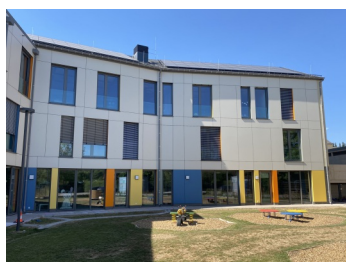
Bâtiment Maison Relais sous-sol
