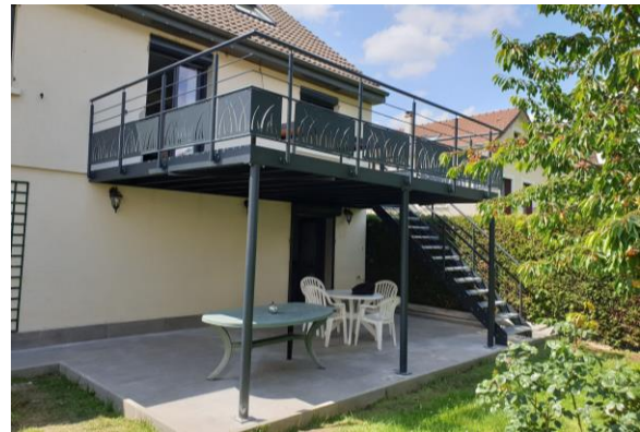
Figure 16 : exemple de terrasse aménagée sur pilotis
