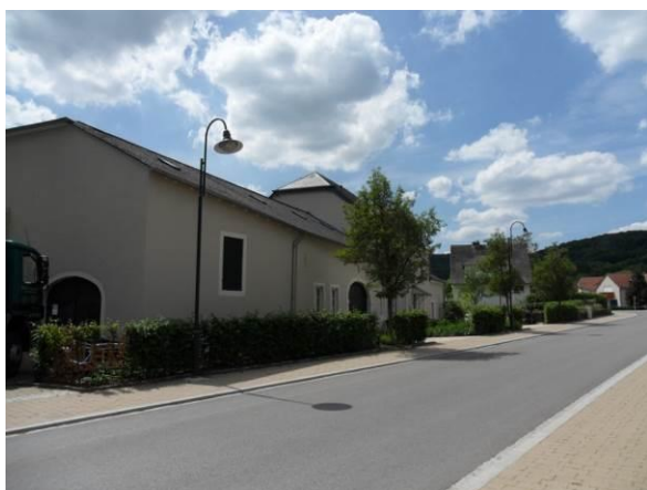
25, rue Principale – corps de logis + annexes
