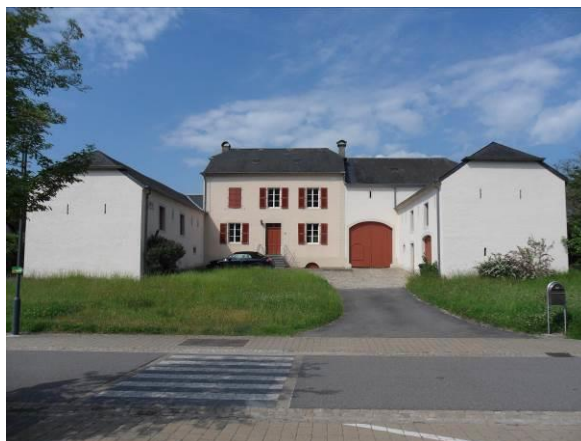
24, rue de l'Eglise – immeuble
