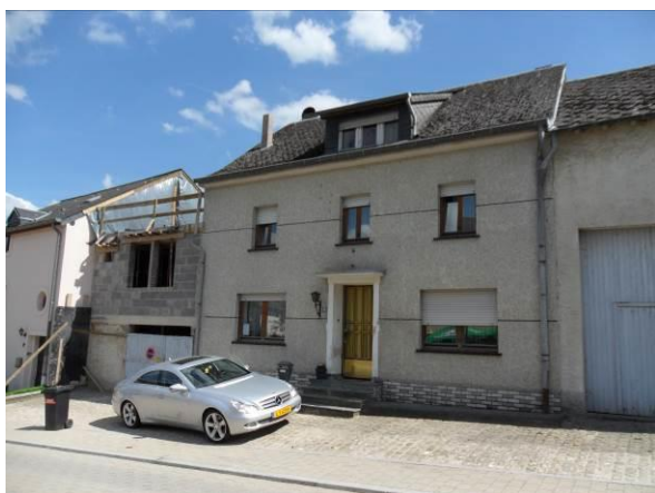
33, rue Principale – bâtiment dans son ensemble
