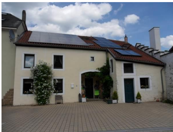
4, rue de Trintange – bâtiment dans son ensemble
