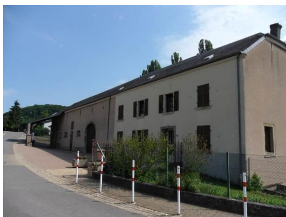
21, rue de l'Eglise – corps de logis + annexes → façade avant
