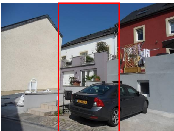
3A, rue de la Forge – volume principal
