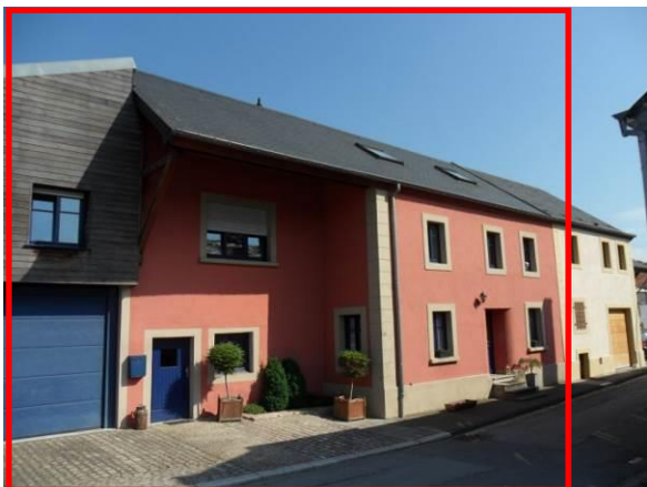
1, rue de la Forge – bâtiment dans son ensemble
