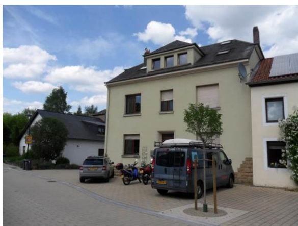
6, rue de Trintange – bâtiment dans son ensemble
