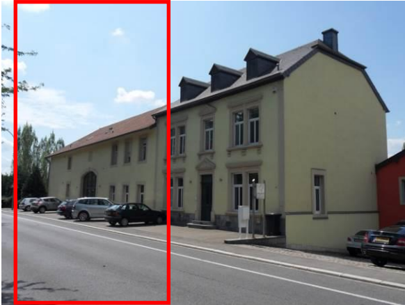
56, route de Remich – bâtiment dans son ensemble
