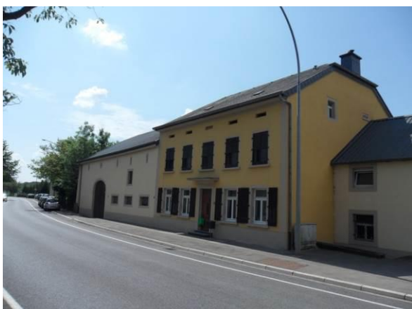
52, route de Remich – corps de logis + annexes
