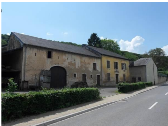
1, rue de Gondelange – annexes + corps de logis
