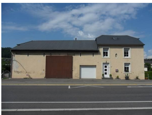
30, route de Remich – corps de logis + annexes
