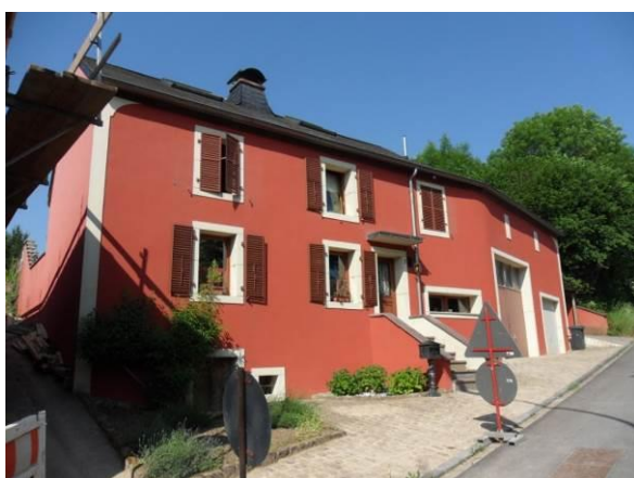
3, rue de Moutfort – bâtiment dans son ensemble
