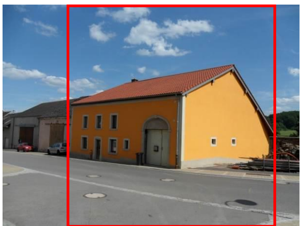
39, rue Principale – corps de logis + annexe
