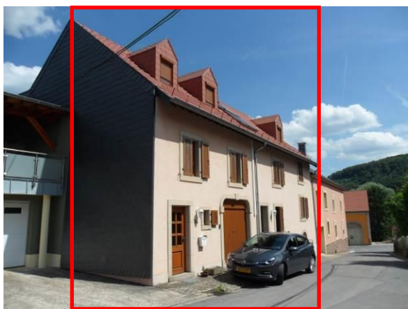
2, rue des Champs – bâtiment dans son ensemble
