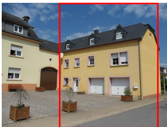
10A, rue Principale – bâtiment dans son ensemble
