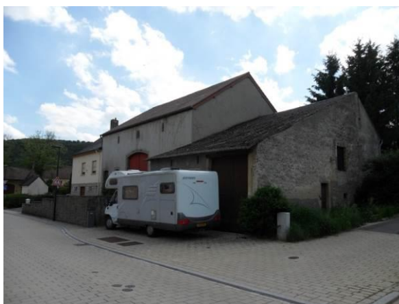
1, rue de Trintange – corps de logis + annexes
