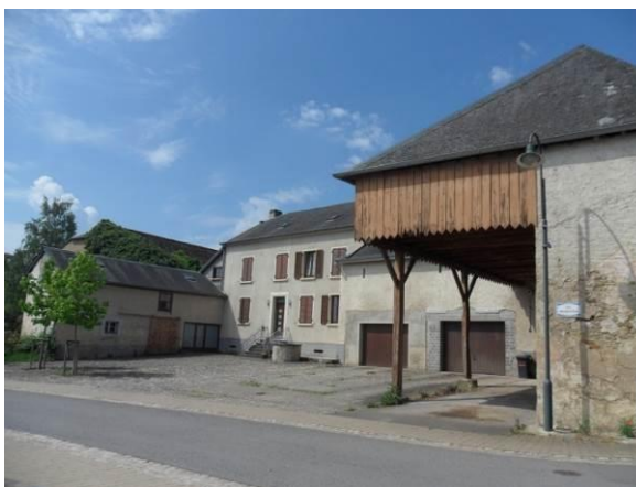
16, rue Principale – corps de logis + annexes
