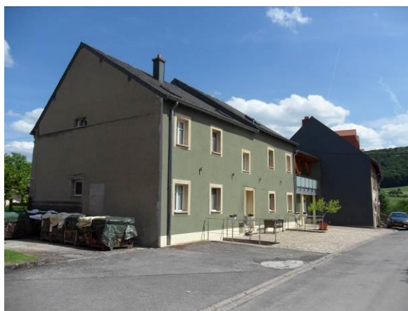
4, rue des Champs – bâtiment dans son ensemble
