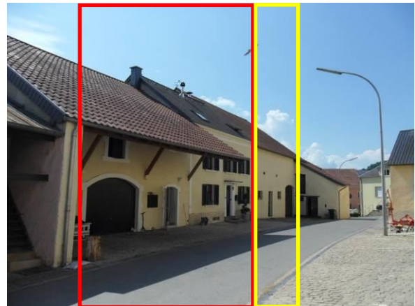
4, rue du Coin – corps de logis + grange gauche (voir cadre rouge) + grange droite (voir cadre jaune)
