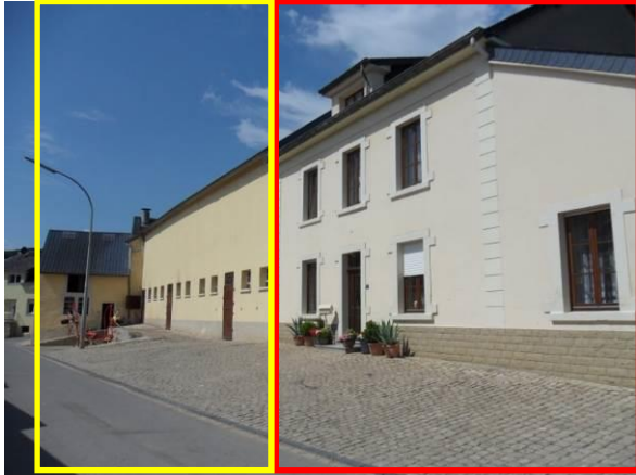
1, rue du Coin – ancien corps de logis et annexe mitoyenne + grange septentrionale (voir cadre rouge) + étables (voir cadre jaune)
