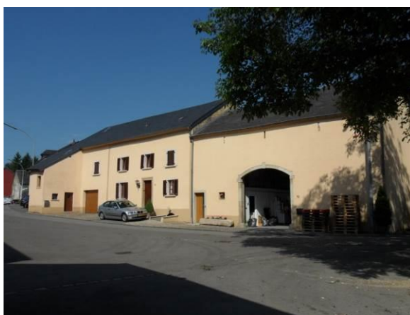
11 - 13, rue du village – corps de logis + annexes
