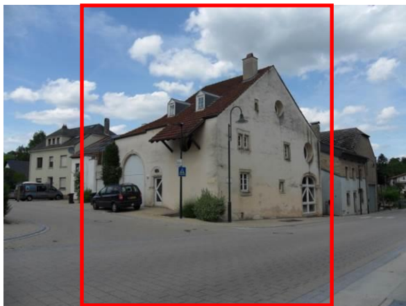
2, rue de Trintange – corps de logis + annexes
