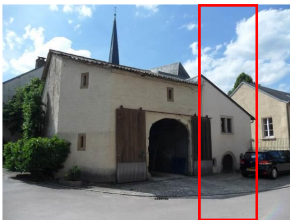
Rue de Wiltheim – ancien bâtiment des pompiers → côté rue de l'Ecole
