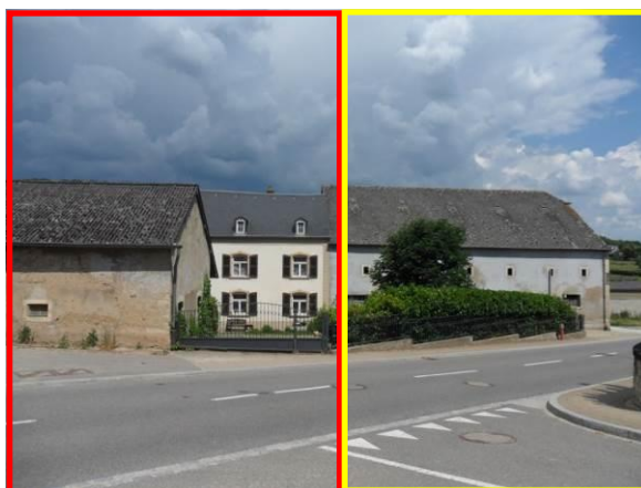
2, rue du Gondelange – moulin, corps de logis (voir encadré rouge) + annexe (p. partie, voir encadré jaune)
