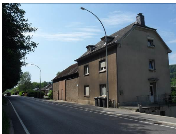
34, route de Remich – corps de logis + annexes
