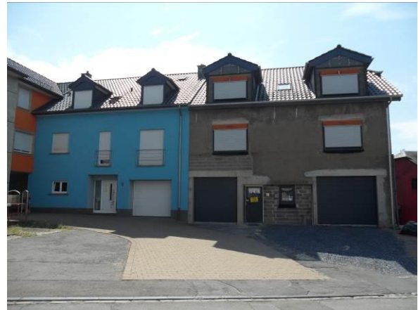
4a, 4b, 4c, rue de Canach – bâtiments dans leur ensemble
