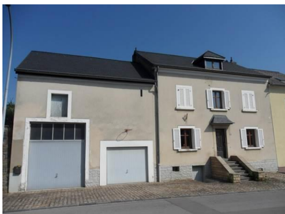
7, rue du village – corps de logis + annexes
