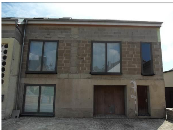
15, rue Principale – bâtiment dans son ensemble
