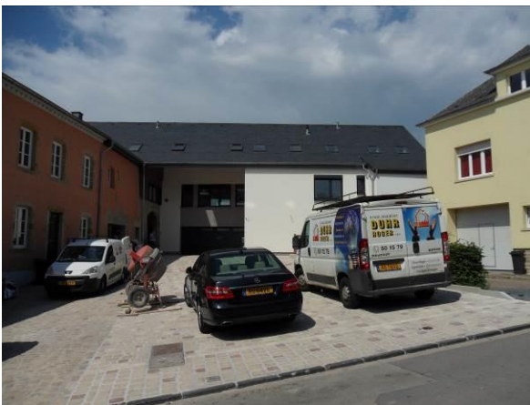
1B, 1C, rue du Bassin – bâtiment dans son ensemble
