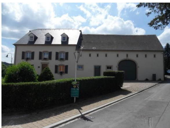
56, rue Principale – corps de logis + annexes
