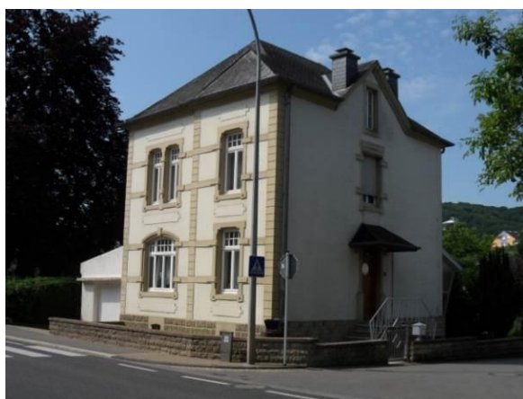
1, rue Principale – bâtiment dans son ensemble
