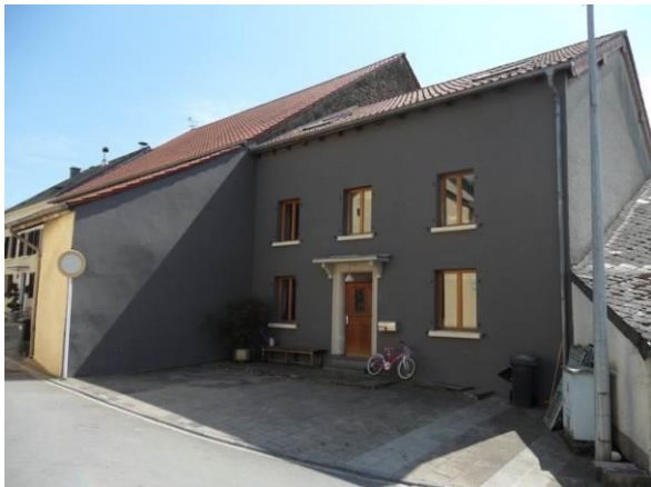
2, rue du Coin – bâtiment dans son ensemble
