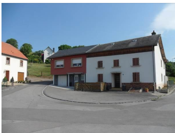
10-12, rue du Village – bâtiments dans leur ensemble
