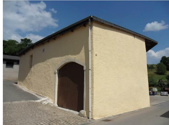
1, rue du Coin – corps de logis + annexes (ici : vue sur grange septentrionale, détachée du corps de logis)
