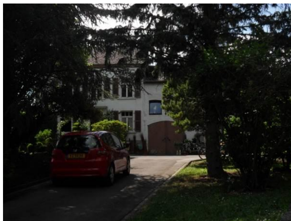
1, rue du Kiem – corps de logis + annexes → façade avant
