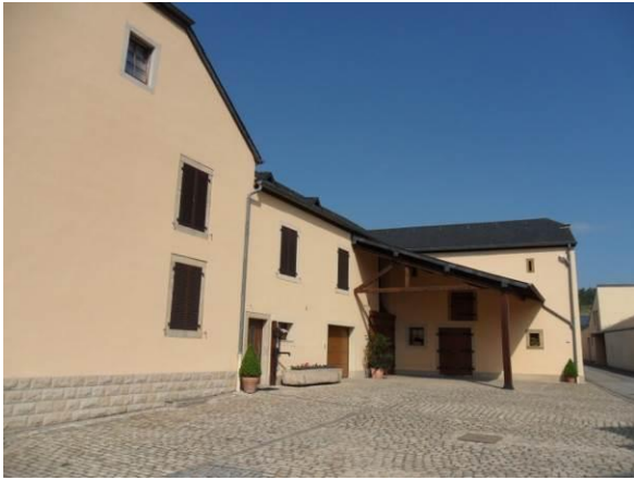
15, rue du village – corps de logis + annexes
