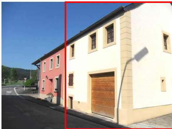
1a, rue de la Forge – bâtiment dans son ensemble
