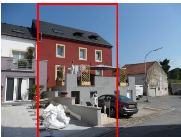
3, rue de la Forge – volume principal
