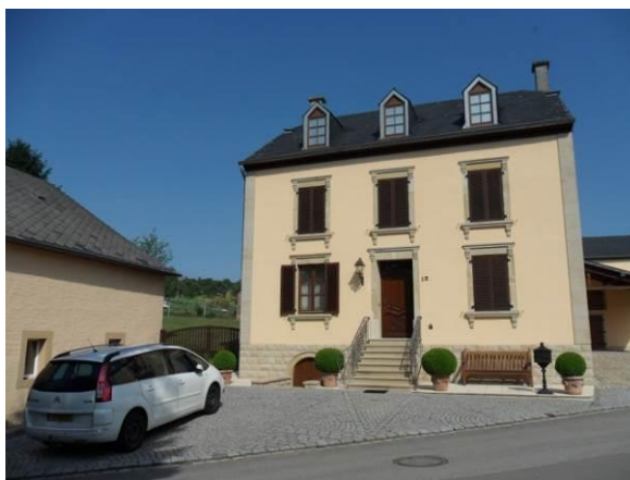
15, rue du village – corps de logis + annexes
