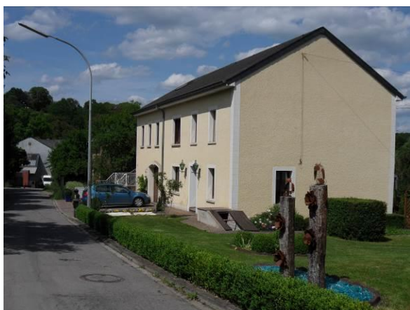
10-12, rue des Champs – bâtiment dans son ensemble
