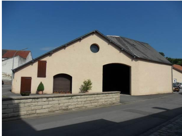
19, rue du village – bâtiment dans son ensemble
