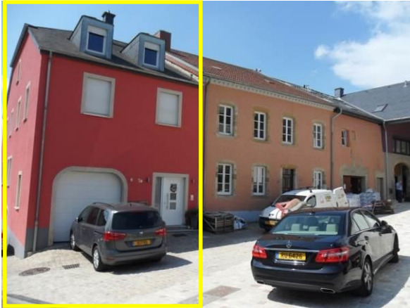
1A, rue du Bassin – bâtiment dans son ensemble
