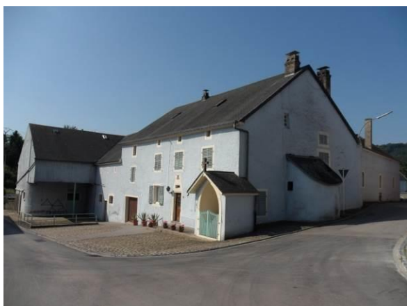
2, rue du village – corps de logis + annexes → depuis la rue de Moutfort
