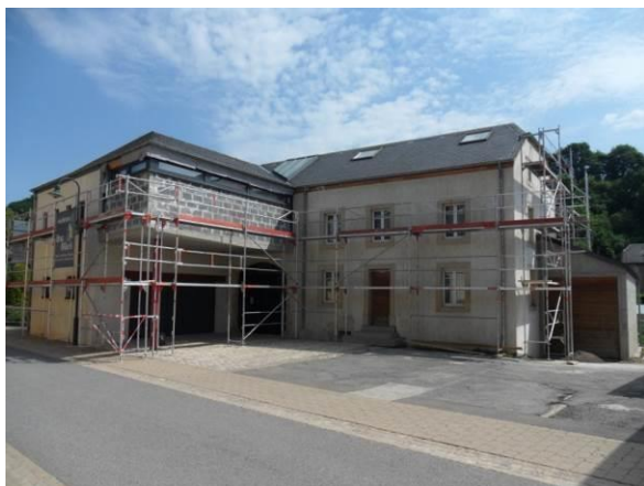
11, rue Principale – bâtiment dans son ensemble
