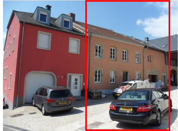
1, rue du Bassin – bâtiment dans son ensemble
