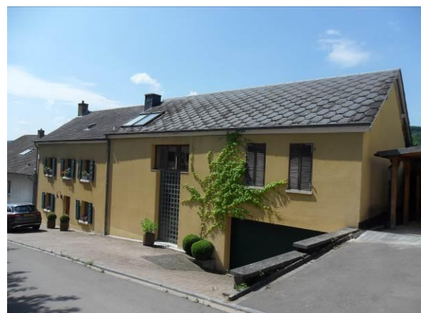
11, rue du Bassin – bâtiment dans son ensemble
