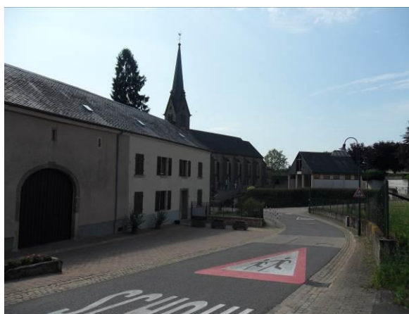
Trintang, rue de l'Eglise – l'église de Trintang avec son mobilier et le cimetière adjacent
