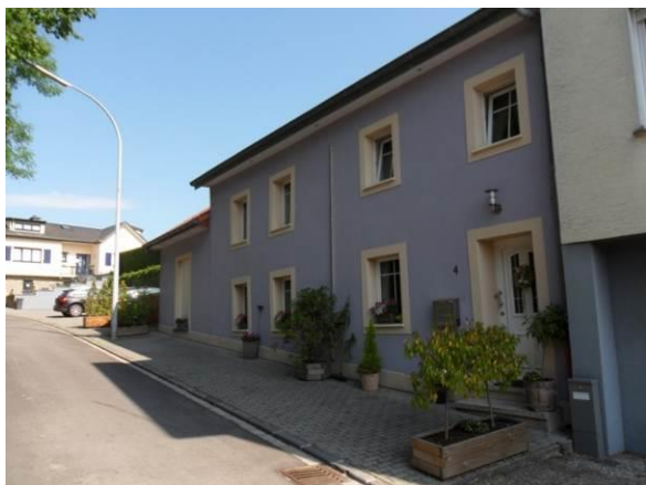
4, rue de Moutfort – bâtiment dans son ensemble
