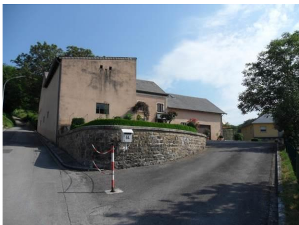
14, rue du Village – corps de logis + annexes
