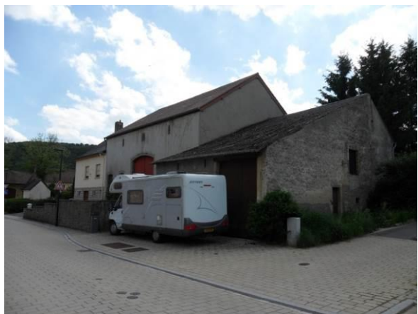
1, rue de Trintange – corps de logis + annexes
