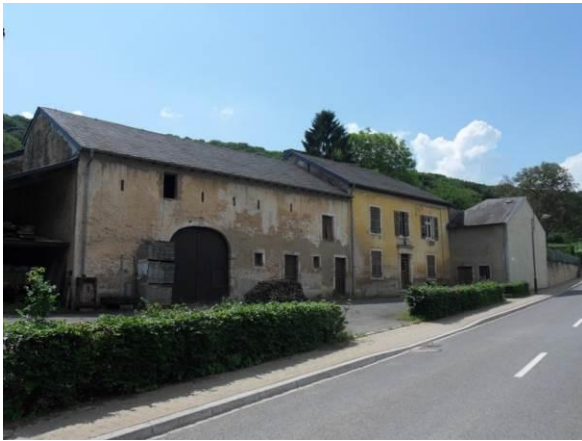
1, rue de Gondelange – annexes + corps de logis
