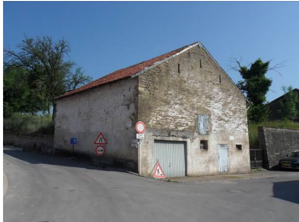
Rue de Moutfort / rue du village – grange
