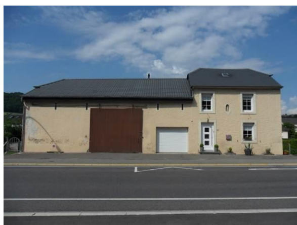
30, route de Remich – corps de logis + annexes
