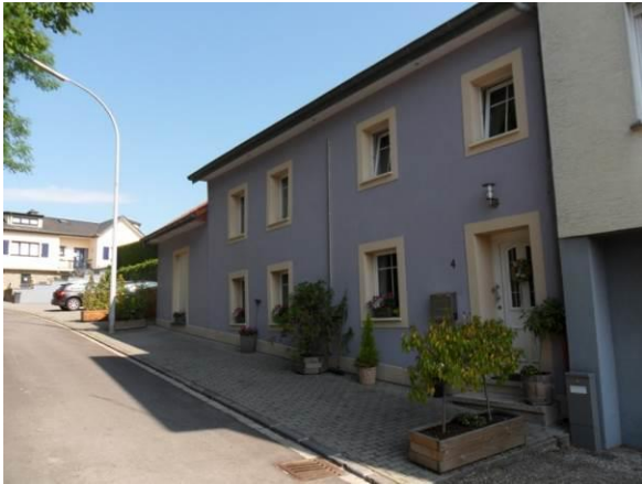
4, rue de Moutfort – bâtiment dans son ensemble
