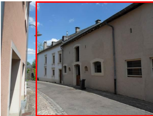
8, rue Wiltheim – corps de logis + annexes
