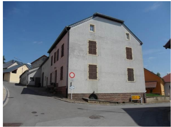
4, rue du Bassin – corps de logis + annexes
