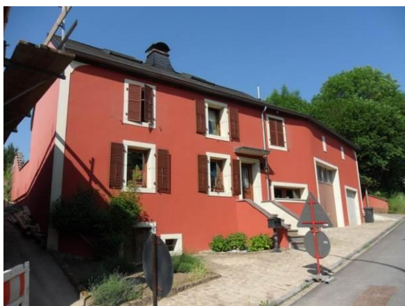
3, rue de Moutfort – bâtiment dans son ensemble
