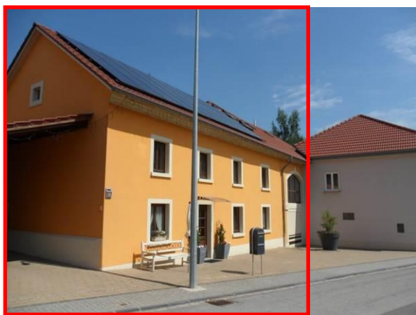
5, rue de Canach – volume principal
