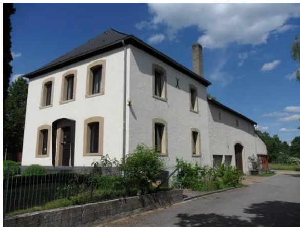
3, rue de l'Ecole – corps de logis + annexes
