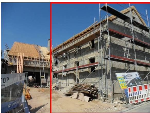
1, rue de Moutfort – volume principal
