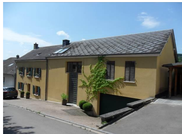
11, rue du Bassin – bâtiment dans son ensemble
