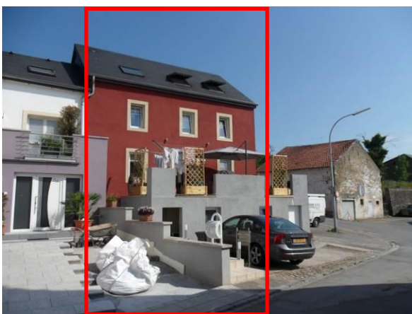
3, rue de la Forge – volume principal
