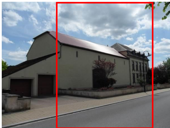
15, rue Principale – corps de logis + grange
