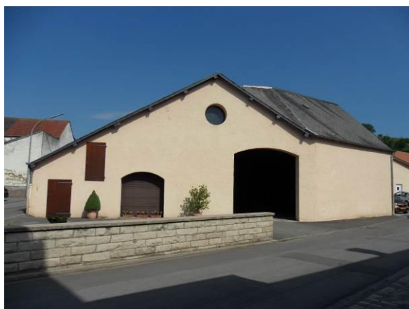
19, rue du village – bâtiment dans son ensemble
