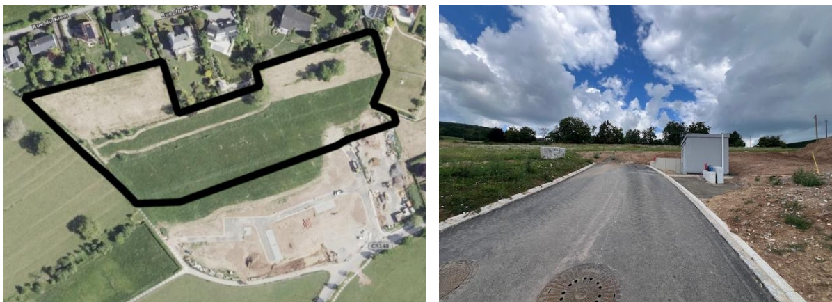
Abb.8: Darstellung der Erschließungsarbeiten des PAP „Routsteck – Phase 1“ (links) mit Darstellung der Erschließungsstrasse Phase 1 (rechts), www.geoportail.lu, 2025.
